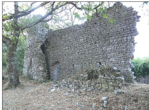
Ruderi della chiesa di San Lorenzo al Caprione, rovinata perché costruita sull'incrocio di una faglia e di una linea d'acqua. All'interno il geo-radar ha mostrato una grande vano sotterraneo a forma rettangolare (una cisterna o un mitreo?).
